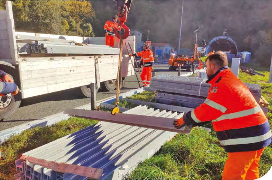
Sopra, i lavori di ammodernamento delle barriere di sicurezza (guard rail) lungo la tratta La Spezia - Sestri Levante. Sotto, gli interventi di messa in sicurezza di 13 gallerie che rientrano nella Rete Ten (la rete stradale transeuropea dei trasporti) [Foto: Salt Spa]
