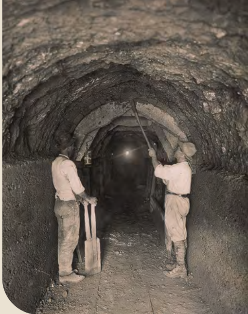
Lavori di costruzione dell'acquedotto di Lerici nel 1924 (sopra) Prova del primo pozzo in località Frati di Camaiole nel 1924 (sotto) [Foto: Archivio Società Acquedotti Tirreni]
