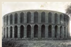
Il Serbatoio del termo in una foto del 1930 (sopra) I lavori di posa dell'acquedotto in frazione Marota nel 1924 (sotto) [Foto: Archivio Società Acquedotti Tirreni]
