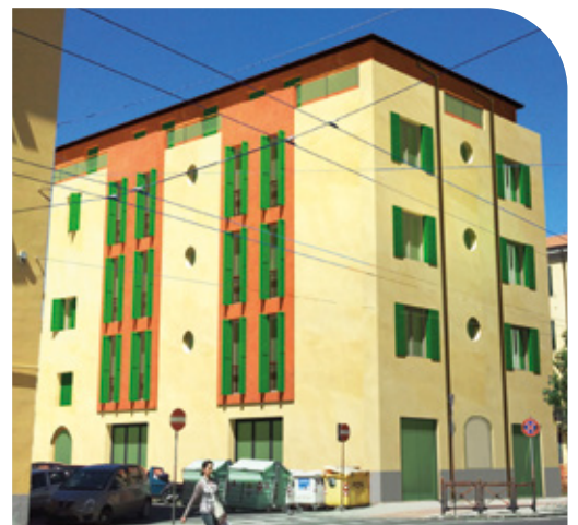
L'ex Liceo Pacinotti di La Spezia, prima e dopo l'intervento di ristrutturazione realizzato all'interno del programma Contratto di Quartiere
