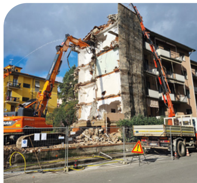
Una fase della demolizione (a destra) e una foto aerea della ricostruzione (sopra) degli edifici siti in via Bologna alla Spezia, attuata dall'Arte ricorrendo ai benefici del Superbonus 110%
